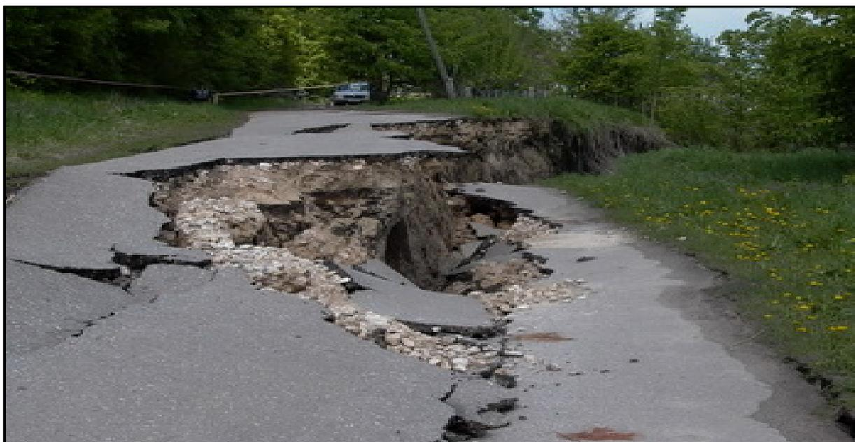
Рис. 3. Часть автомобильной дороги, ведущей к храму Воскресения Христова в селе Исады (разрушена фронтальным блоковым оползнем)
